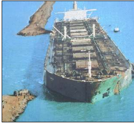
〈 서산방조제 물막이 공사 〉
